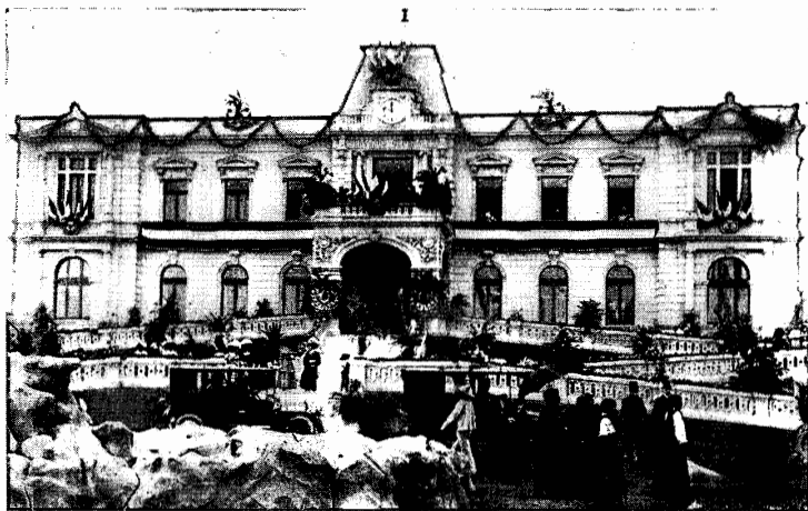
Fachada del Manicomio de La Castañeda adornada con motivo de su inauguración, 1910.
